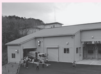
▲平成26年1月から、ごみ積替え施設が稼働開始しています。
