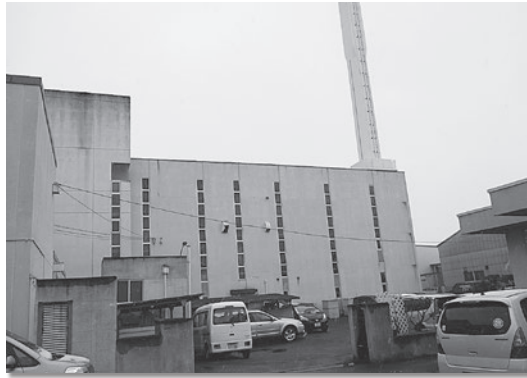
平成26年度から解体撤去工事をすすめています。
