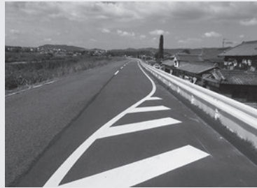
▲町道437号線（大字目安） 道路が拡幅され、車が通りやすくなりました。
