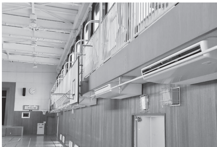
▲ 体育館でのエアコンの設置状況
