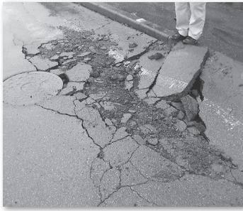
水圧による舗装などの破損
