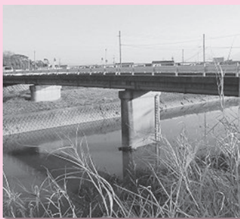
富雄川にかかる米壽橋。幸前2丁目と高安1丁目を結んでいます。
