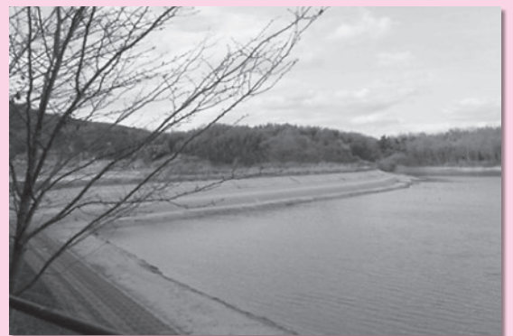
いかるが溜池において、公園施設の整備などをすすめます
