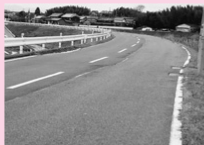
▲ 町道437号線(目安地内の大和川堤防)の道路整備
