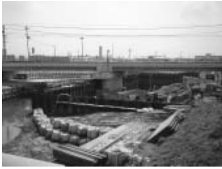
富雄川の改修(JR鉄橋付近)
