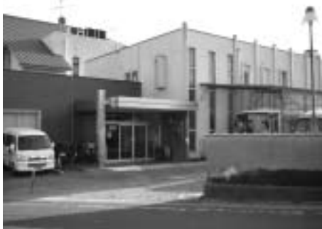
老朽化した斑鳩町福祉会館
