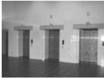
町営火葬場 火葬炉
