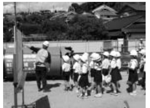
小学生による公共下水道施工現場の勉強会
