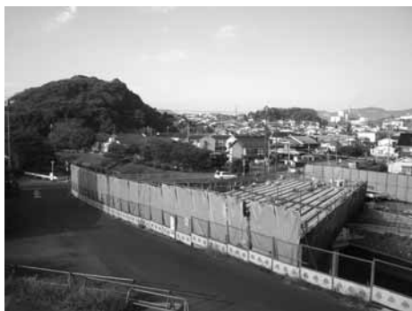
新岩瀬橋工事と三室山（平成21年9月）
