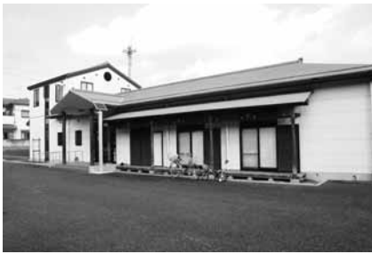
▲消防コミュニティセンター
