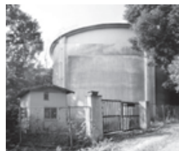
▲老朽化がすすんだ北部配水池
