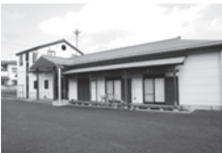
▲消防コミュニティセンター
