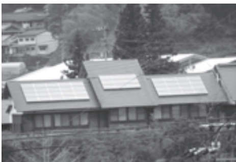
▲太陽光パネル
