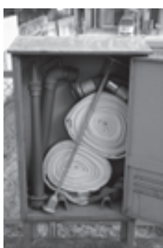
▶ 消防器具の格納箱
