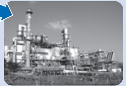
委託先の三重中央開発(株)、ごみが焼却される。
