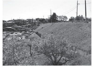
▲令和3年度、奈良県により耐震補強工事が実施予定の桜池の堤体
