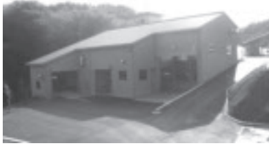
▲斑鳩町ごみ積替え施設
