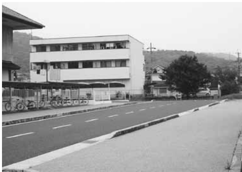
▶法隆寺線整備事業の国道25号取り付け部分
