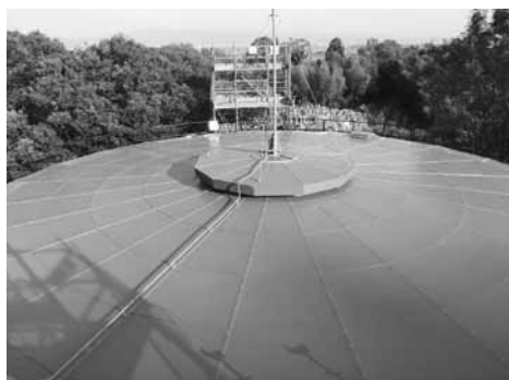
▶新しくなった 北部配水池ドーム(屋根)
