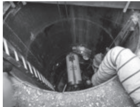
▶下水道工事のようす
