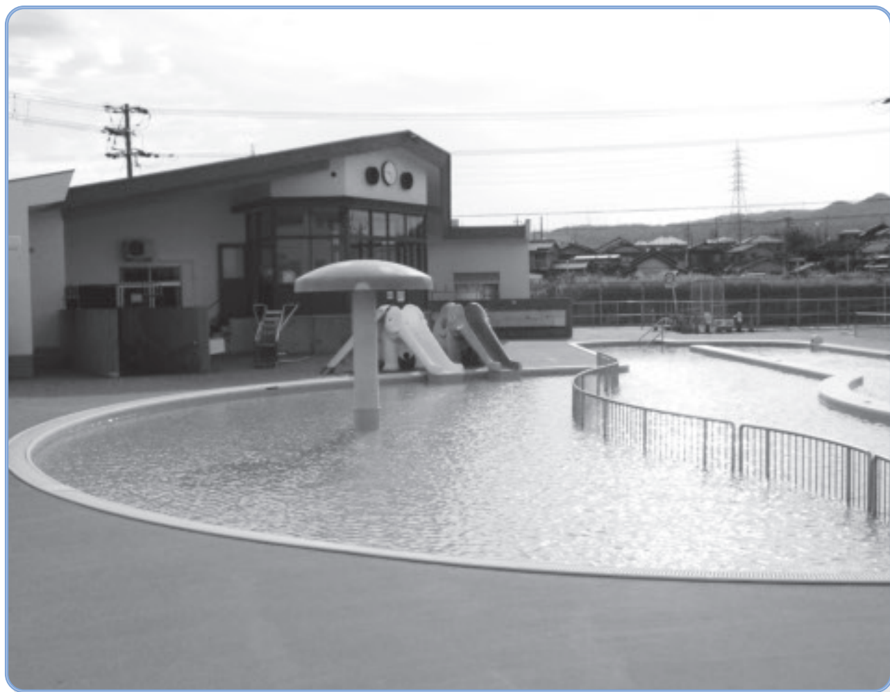
▲改装なった町民プール
