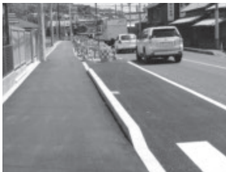
▶整備途中の歩道
