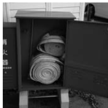
▶消防器具の格納箱
