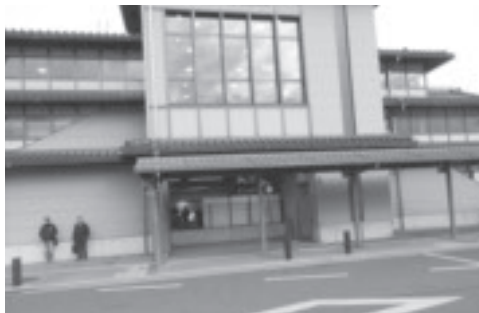
▲JR法隆寺駅南口駅前広場エレベータ付近
