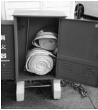
▶ 消防器具の格納箱
