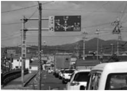
▲竜田大橋東詰の電柱
