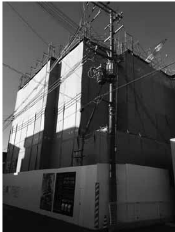
▶駅北側のマンション建設現場
