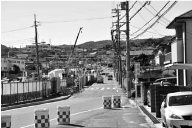
▶整備工事が行われている岩瀬橋西詰から三室交差点までの区間
