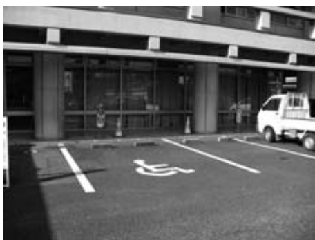
▶ 役場 障がい者用駐停車スペース
