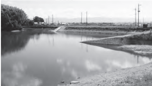
▲令和3年度より耐震補強工事が実施されている桜池
