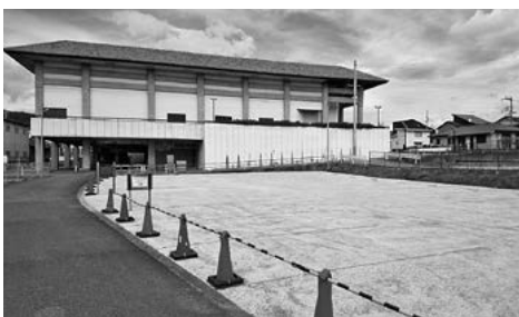
▲完成間近の第二駐車場（中央公民館）
