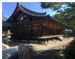
法隆寺東院伽藍の保存修理工事後の様子（R1）
