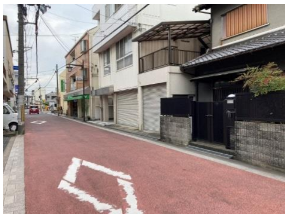
駅北口へのアクセス道路の一部
