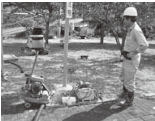
▶十津川村での斑鳩町職員の出遣の様子（配水管の新設作業）
