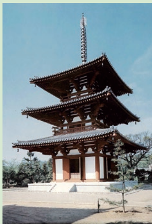
▲再建当時の法輪寺三重塔
