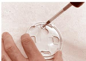
天井または壁面に、取付ベースをネジで取り付けます。
