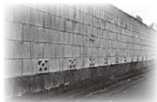
コンクリートブロック塀
