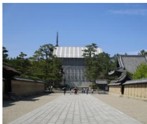
法隆寺保存修理工事(国宝中門)
