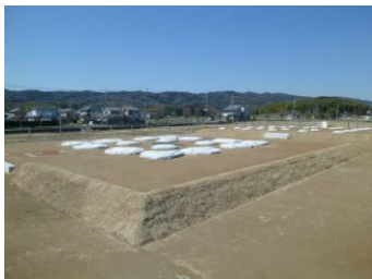
史跡中宮寺跡整備工事
