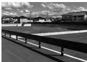
▲法隆寺北1丁目地内で整備中の貯留施設
