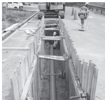
▲下水道管埋設工事
