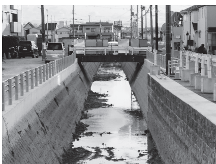
▲河川改修工事中の三代川
