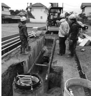
▶下水道工事の様子
