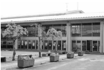
▲令和6年度にエアコンが設置される 中央体育館
