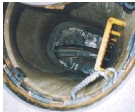
固着油分除去（通常の状態）
