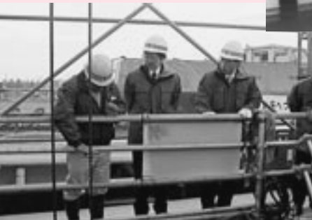
小吉田1丁目の工事現場を見学
