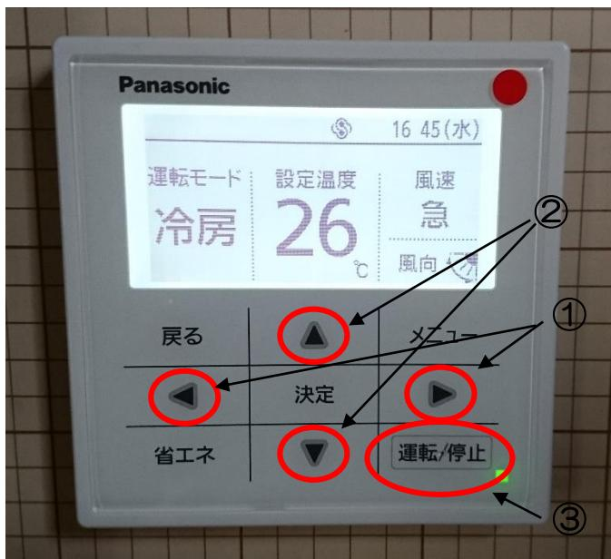
①左右の◀▶ボタンにて、設定温度、運転モード、風速風向の切換ができます。
