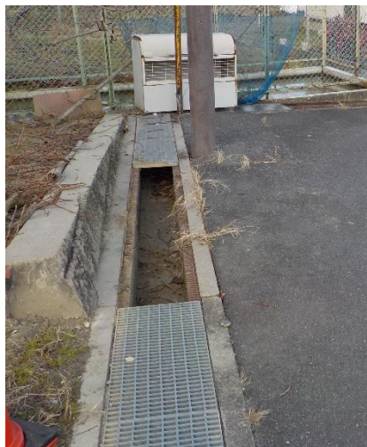
側溝に設置されていたグレーチングが盗まれた状況
