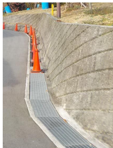
側溝に設置されていたグレーチングが盗まれた状況
